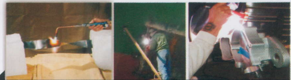
COMPONENTES DEL HORNO, TUBERÍA CALIENTE, TANQUES
