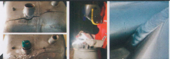
REPARACIÓN, DEFECTOS DE FUNDICIÓN, FISURAS DE CARCASAS DE ALUMINIO
